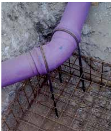
Ejemplos de preparación de anclajes
